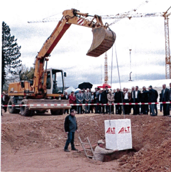
Der Grundstein für das neue Seniorenpflegeheim wurde gelegt.
